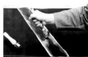
Рис. 11. Прикатывание ленты для заделки стыкового шва
